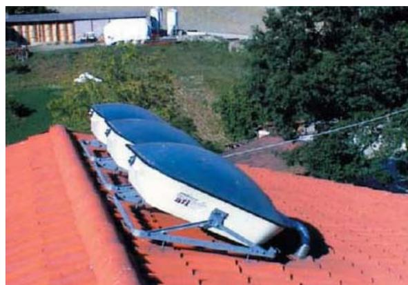
No requiere de instalación de ningún tipo de acumulador adicional, ya que el mismo equipo dispone de un acumulador de agua interno de 135 litros.
